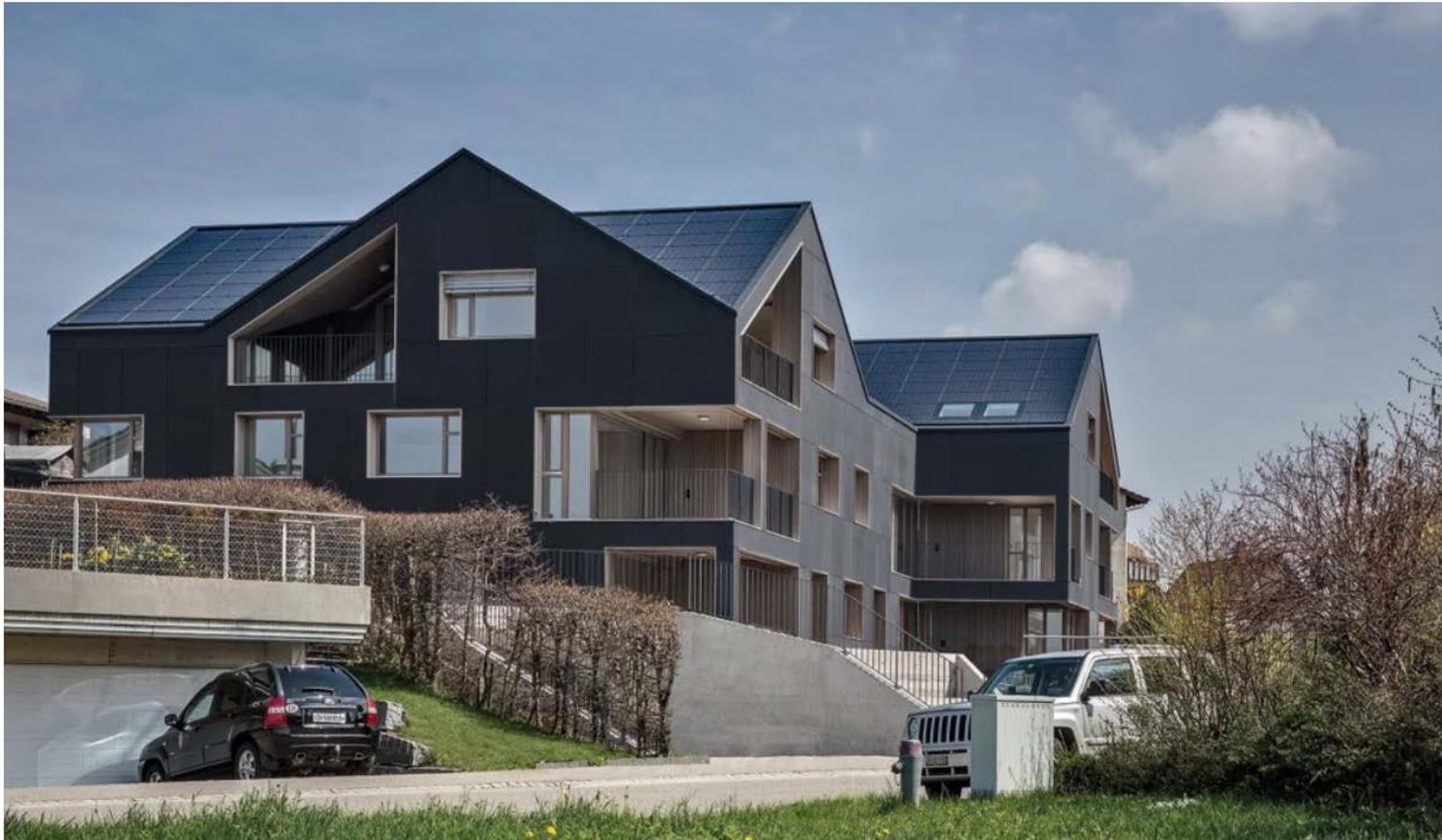
**Das gesamte Gebäude hat eine Hülle aus BIPV-Modulen: Dächer und alle Fassaden**
