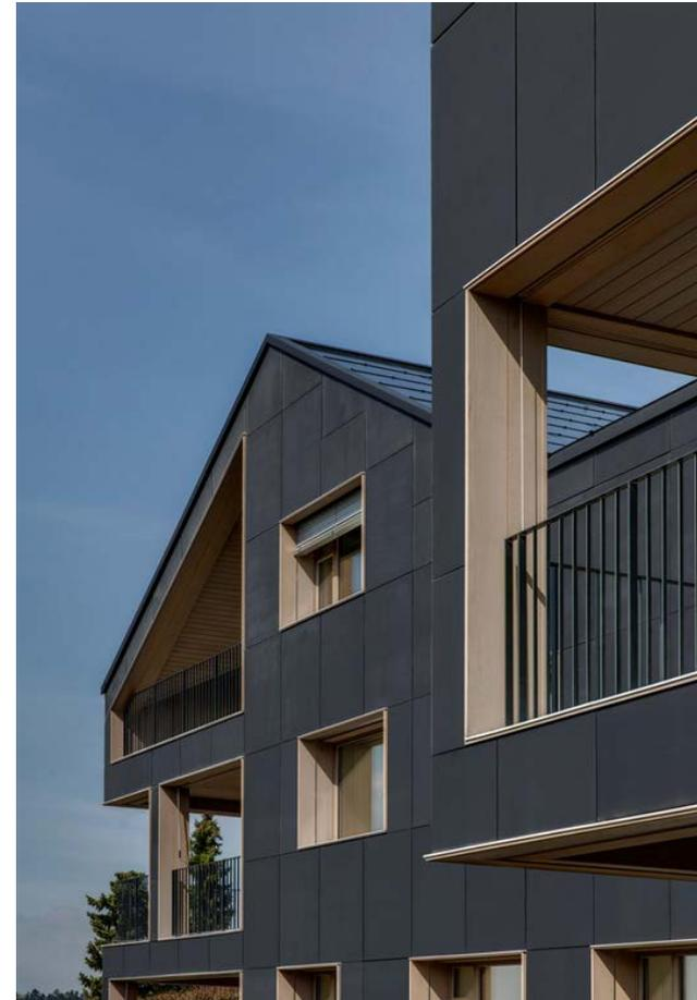
Saisonaler Wärmespeicher, Wasserstoffspeicher und PV-Fassaden aus gesandstrahlten Dünnschichtmodulen sind hier Basis des Energiekonzeptes
