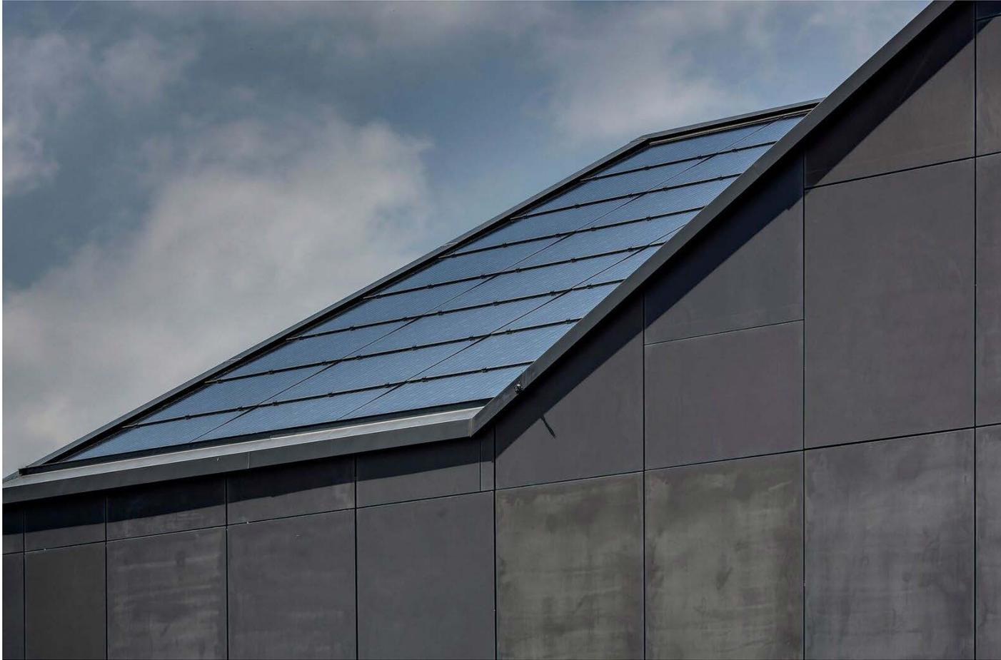
PV-Dachsschindeln und sandgestrahlte Dünnschichtmodule aus ASI als Gebäudehülle
